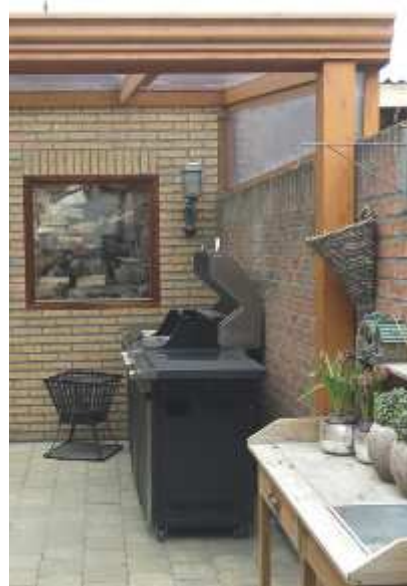
Pergola réalisée en structure bois
