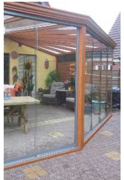
Construction spéciale de toiture en éventail, exécution aspect bois
