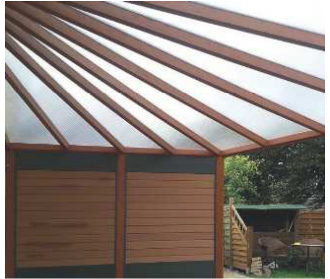
Construction à toit rayonnant et paroi latérale en aluminium/composite
