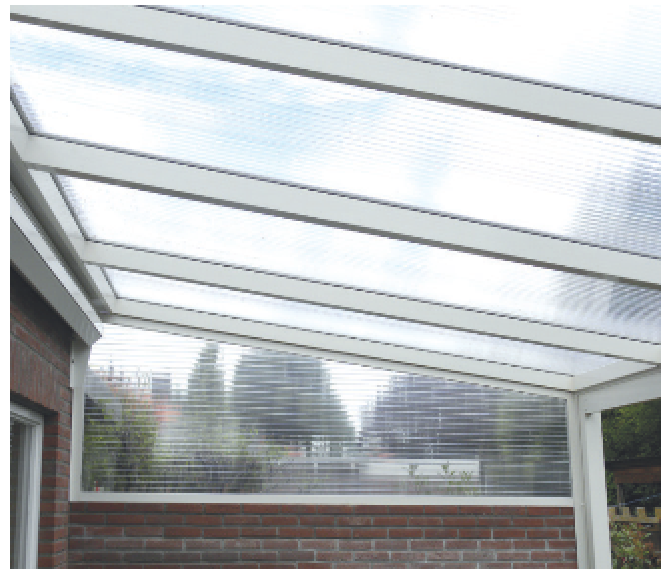
Triangle de dormant avec verre ou polycarbonate
