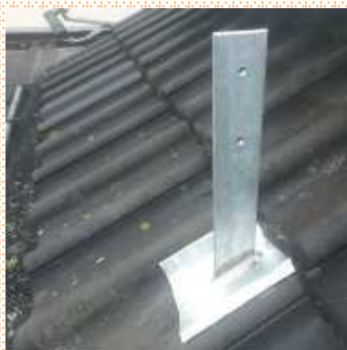
Montage sur tuiles 1
