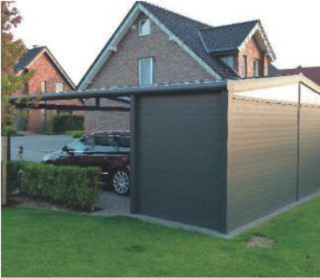
Construction spéciale carport avec toit en bâtière et parois latérales
